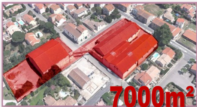
Vue aérienne du site de la Cave Viticole
